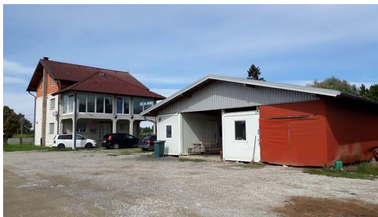
Slika 1. Upravna zgrada sa pomoćnim objektom
