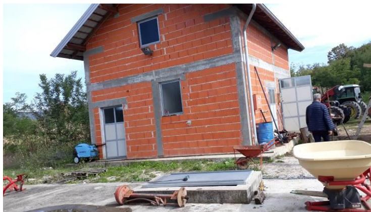
Slika 10. Objekat pumpne stanice i bazen za vodu
