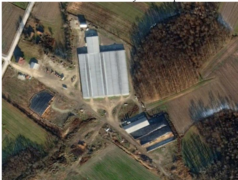
Slika 14. Uža lokacija farmskog objekta
